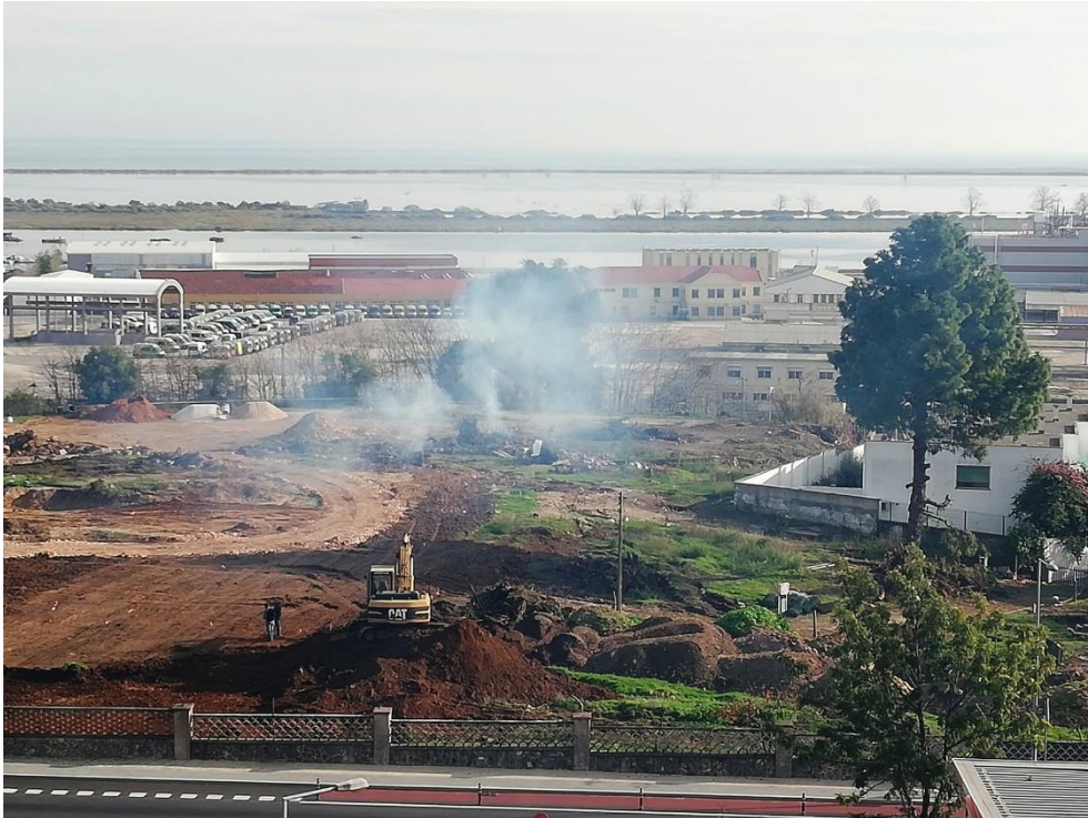
Fig. 3 – O mesmo logradouro durante a execução de obras de edificação.
